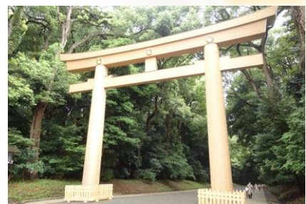
改修工事を終えた明治神宮第一鳥居
