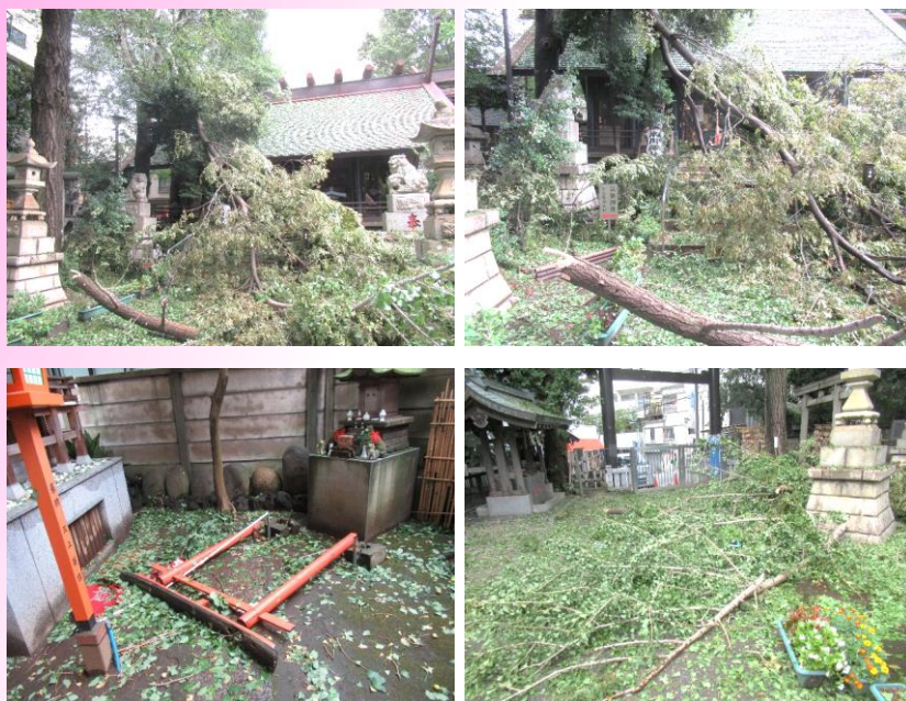
1 2019年9月の台風15号による被害状況
