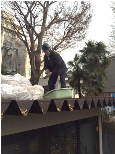
屋根に上った作業
